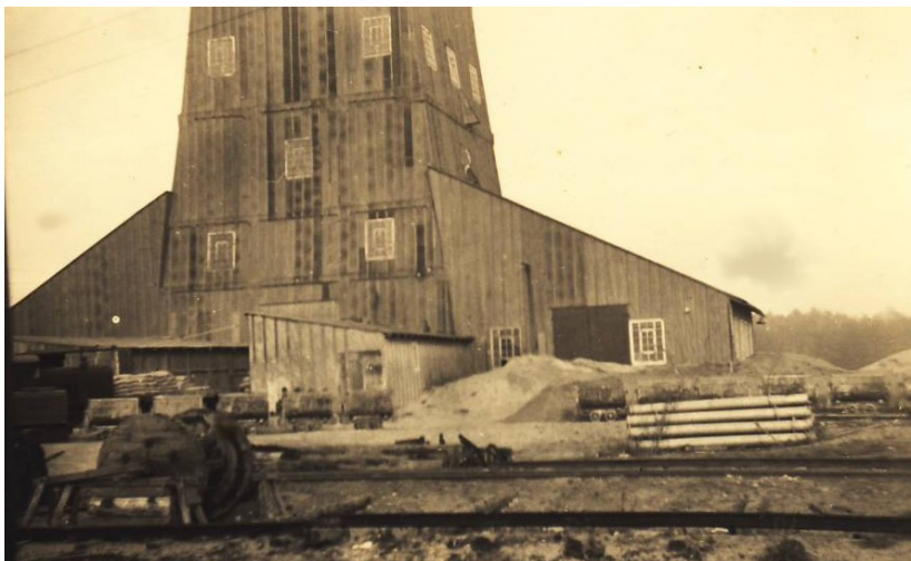
Bau des Schachtes mit Kriegsgefangenen bzw. Zwangsarbeitern, 1943
