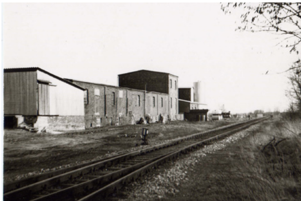
Lagerschuppen am Bahnhof Damme, Strecke Richtung Bohmte, März 1977
