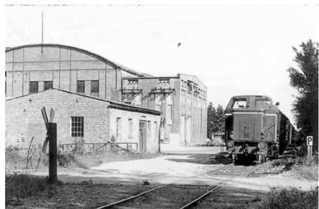
WKB bei der Schweger Moorzentrale, 1977
