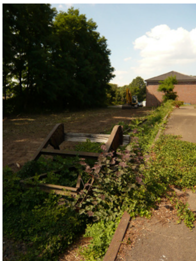
Baubeginn, Planierarbeiten fürs Magazin, 28.08.2013
