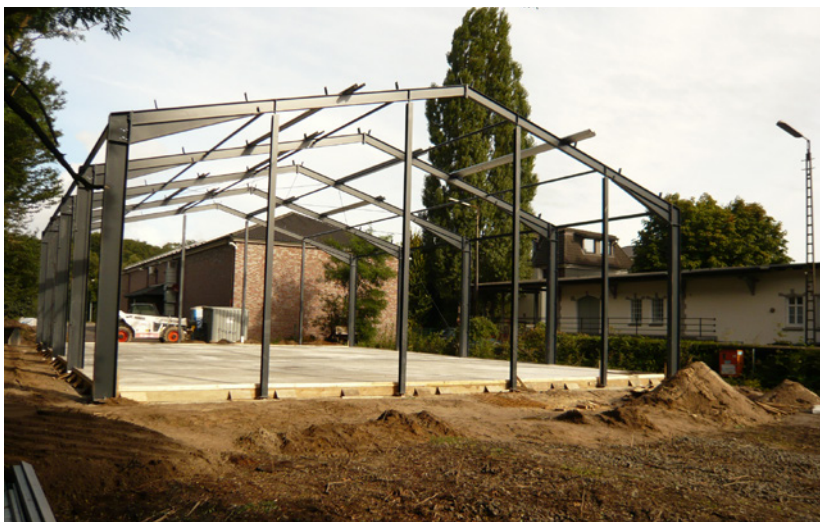
Bodenplatte und Aufbau der Hallenkonstruktion, 21.09.2013
