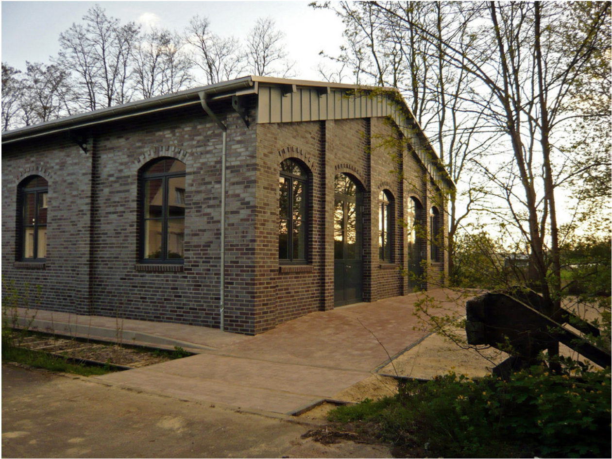
Magazin, Frontseite mit Anpflasterung, 12.04.2014
