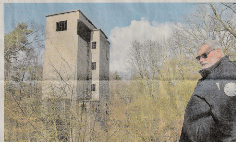
Imposant: Der sogenannte Konzentratbunker ragt immer noch mächtig und kühl aus dem Boden hervor. Naturschützer Ulrich Heitmann kennt sich hier bestens aus.
