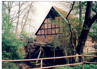
Wassermühle Höltermann, Rückfront mit Wasserrad und Gerinne
