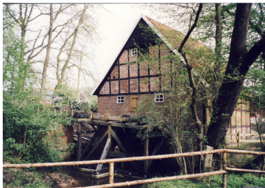
Wassermühle Höltermann, Rückfront mit Wasserrad und Gerinne
