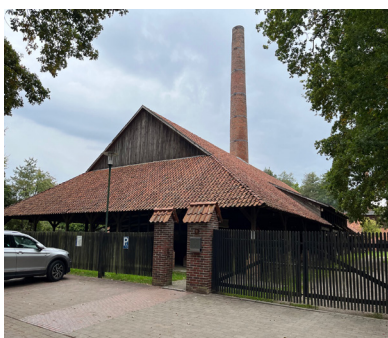
Alte Ziegelei Westerholt, Gesamtansicht
