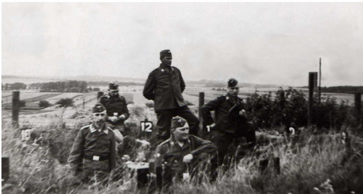
Flakstation bei der Schnatmühle 1943, hier Schanzenbau
